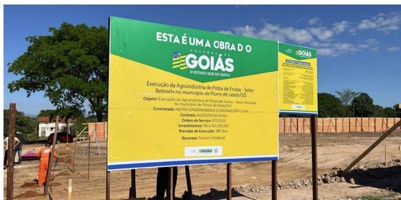
Figura 10 – Construção de agroindústria
