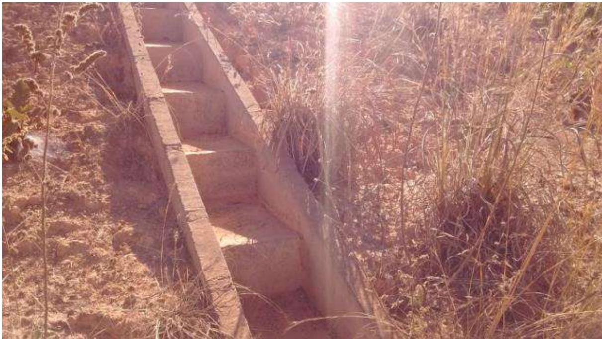
Foram identificadas algumas caixas de medição de vazão durante a inspeção que não são reportadas nos documentos de projeto (Figura 2.9). Não se identificou lamina em "V" ou régua de medição, mas se verificou fluxo. É bem provável que estes dispositivos estejam acoplado as saídas da drenagem interna da barragem.
