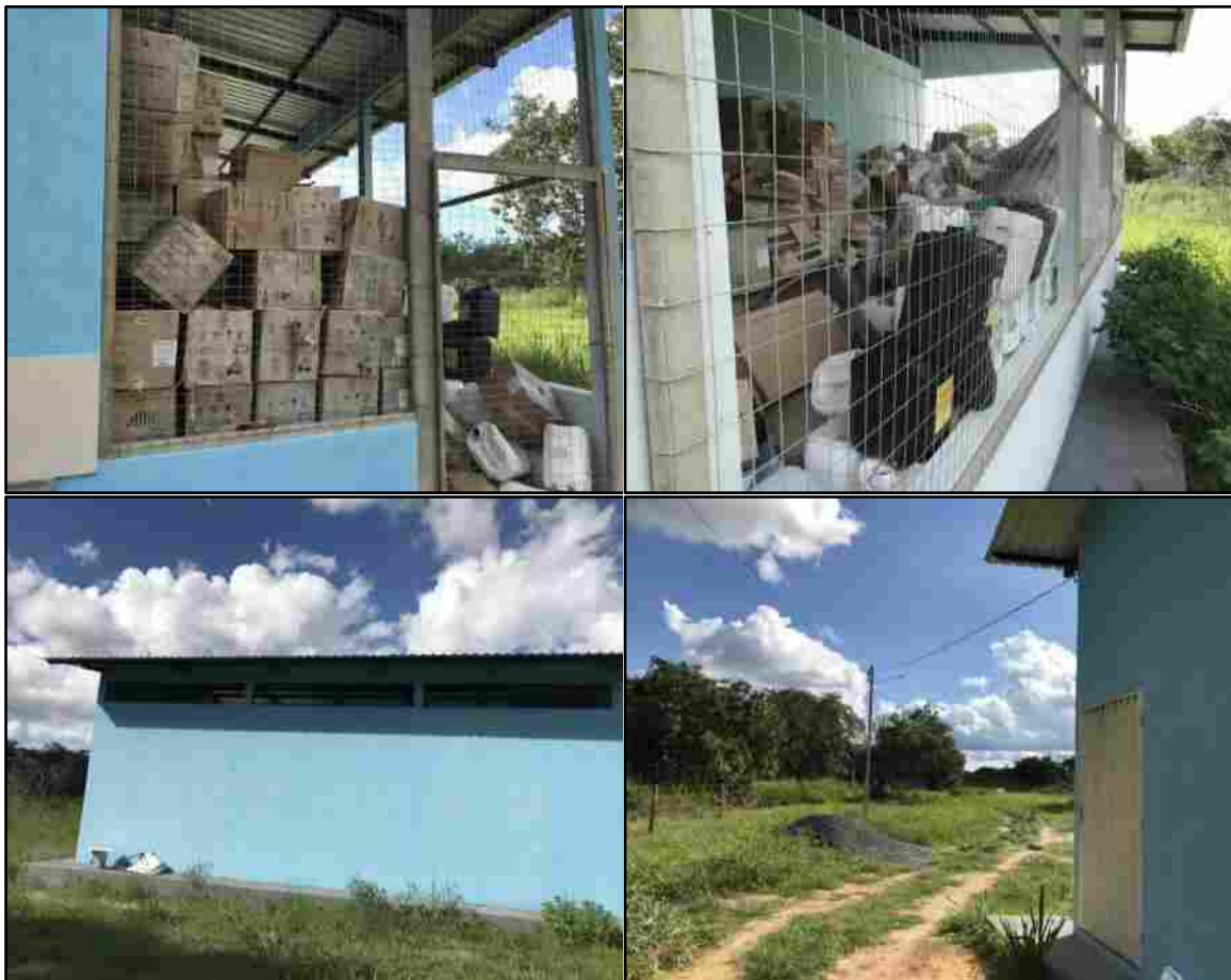
Figura 12. Galpão de armazenamento de embalagens vazias de agrotóxicos das empresas Jaburu e Agrozambo.
