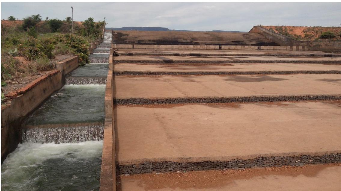
Foto 06: Escada de peixes no vertedouro principal da barragem no rio Paranã, no Projeto de Irrigação Flores de Goiás.
