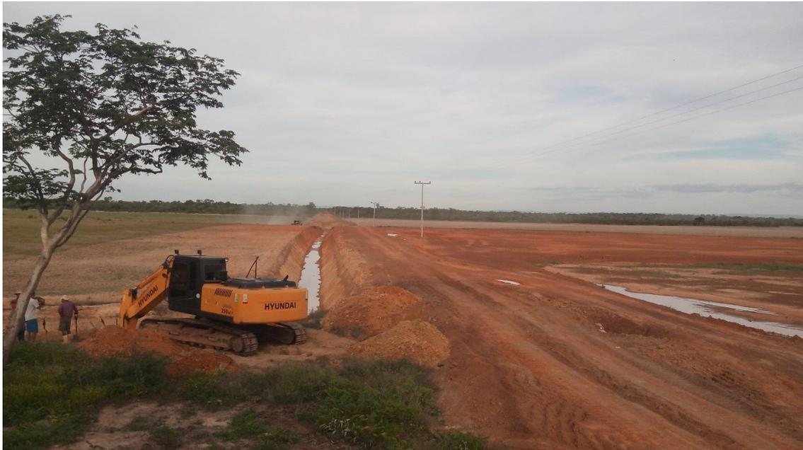
Foto 05: Construção de canais e preparo do solo para plantio de arroz irrigado, em uma das propriedades privadas, com recursos próprios de proprietários rurais, a jusante da barragem no rio Paranã, no Projeto de Irrigação Flores de Goiás.
