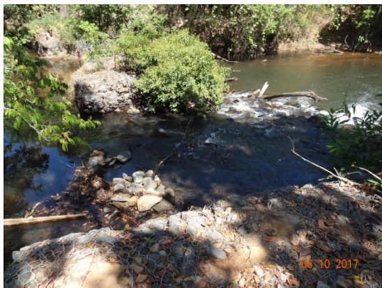
Fotos 3 e 4 – Muro de arrimo construído na área da captação
