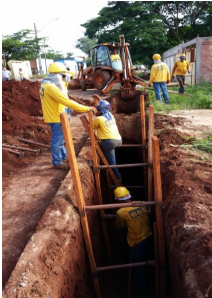
Foto 6 -Ampliação rede de esgotos
