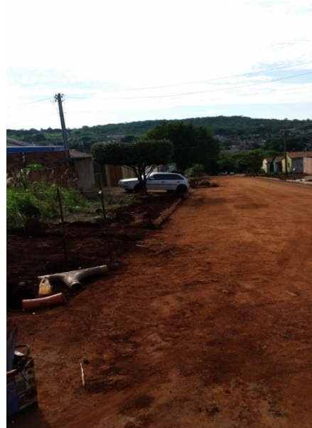
Foto 7 - Ampliação rede de esgotos
