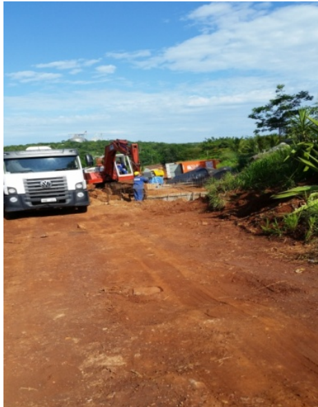
Foto 3 -Obras de instalação de Interceptores - Travessia BR-364
