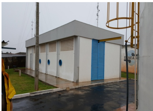
Foto 5 – EEAT Bairro de Lourdes.
