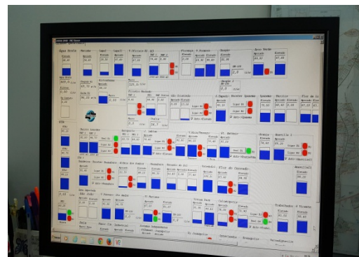
Foto 6 – Sistema Supervisório dos CR's.
