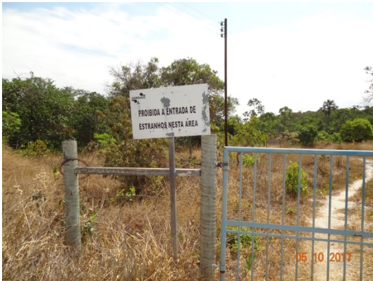
Foto 1 – Captação/EEAB sem placa de aviso de risco e urbanização.
