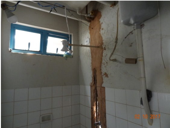
Foto 9 – Edificações do Distrito (em reforma).
