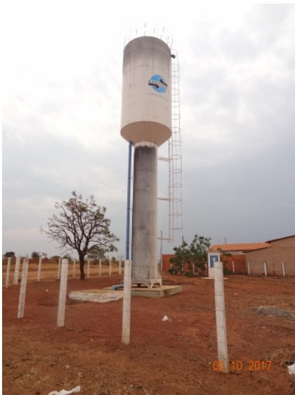
Foto 3 – REL com pintura desgastada.
