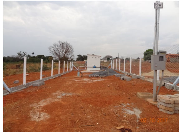
Foto 10 - Poço PGD 144 (poço 06) sendo urbanizado.
