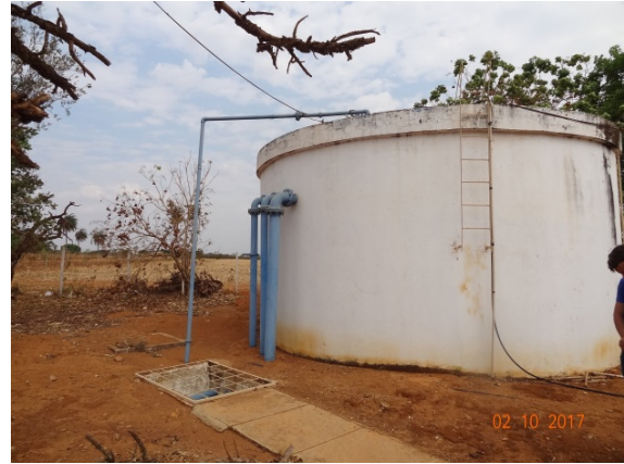
Foto 6 – RAP R1 sem guarda – corpos da escada e cobertura.
