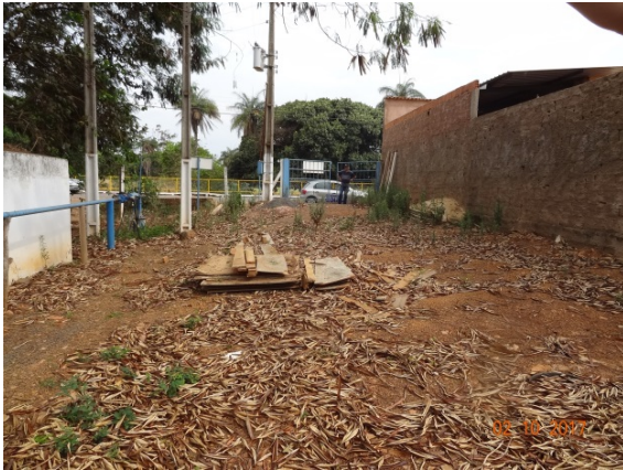
Foto 1 – Poço 04 com mato e entulhos.
