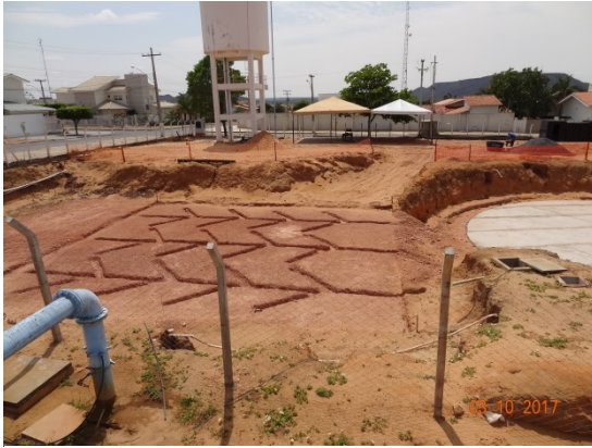
Foto 1 – Obras de ampliação na área da ETA.
