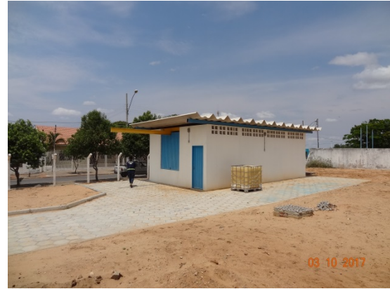
Foto 2 – EEAT construída na área da ETA.
