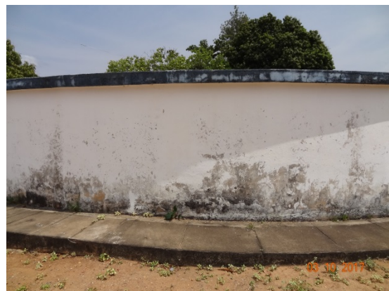
Foto 12 – RSE da parte alta e parte baixa com pintura desgastada.
