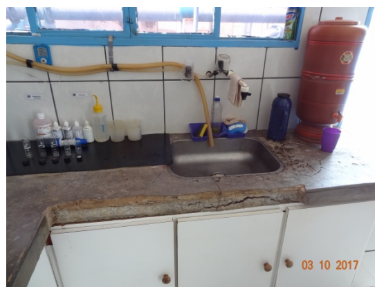
Foto 8 – Sala de química com borda da pia quebrada.
