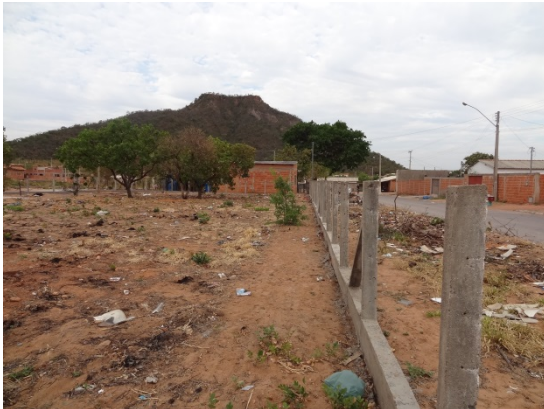
Foto 43 – REL Buenos Aires/Mãe Bela com cerca de proteção em construção.
