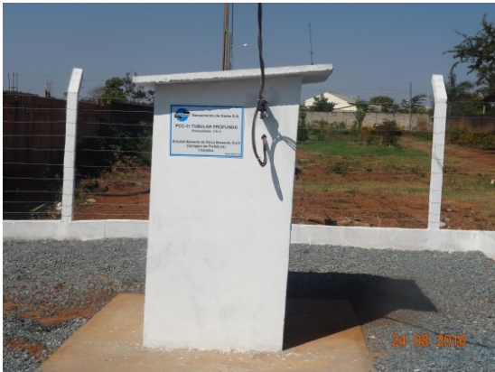
Foto 1 – Poço PCC 11 com identificação adequada.
