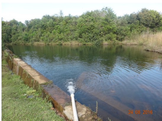
Foto 3 – Água dos poços sendo lançada na barragem de captação superficial
