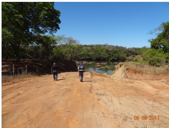
Foto 1 – Corte e aterro de acesso à nova captação Rio das Almas/Ceres
