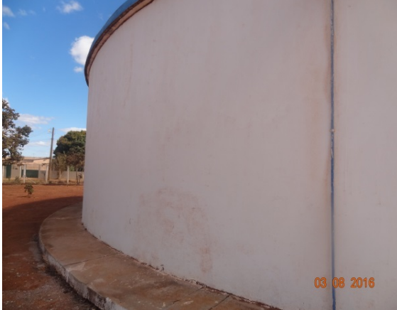
Foto 1 –RAP Itapuã II recuperado
