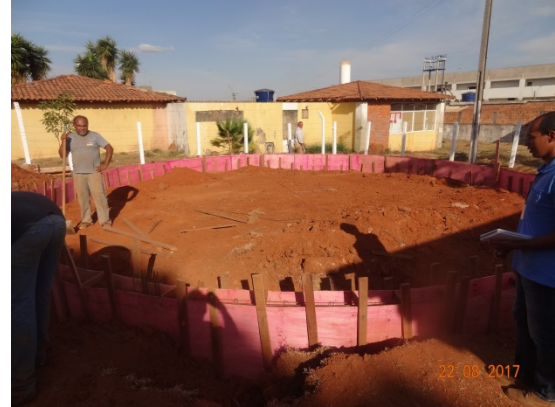
Foto 4 – RAP C.R. Cidade Jardins em construção.
