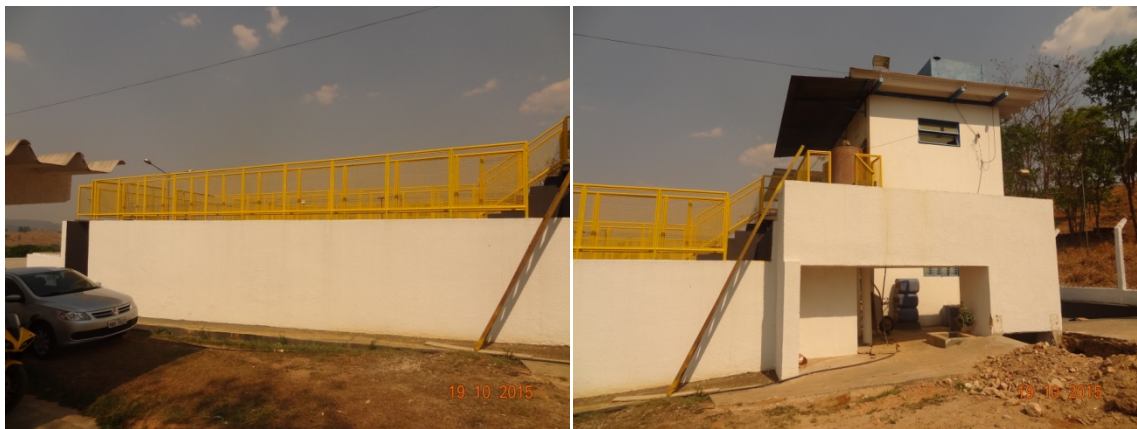
Foto 1 – ETA com pintura recuperada Foto 2 – ETA com pintura recuperada
