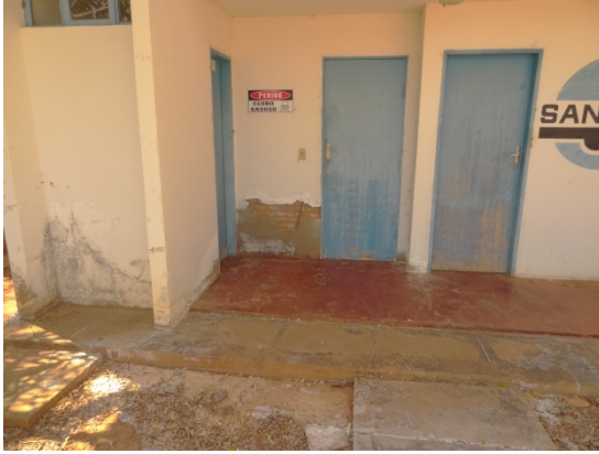
Foto 1 – Placa de aviso de risco instalada sala do clorador.
