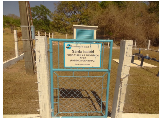
Foto 4 – Poço 02 com cadeado no portão
