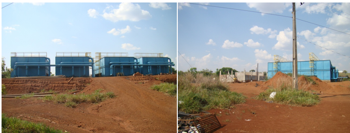
Foto 1 –Obra da ETA Compacta Foto 2 - Obra da ETA Compacta
