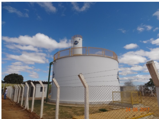
Foto 1 – C.R. Trajanópolis em construção
