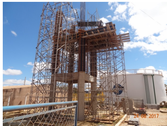
Foto 2 – C.R. Vendinha em construção
