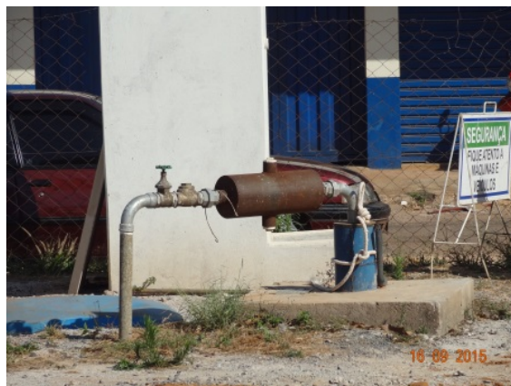
Foto 3 - Poço da ETA
