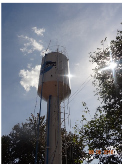
Foto 5 – REL com pintura recuperada.
