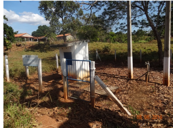
Foto 2 – Poço com cerca de proteção.
