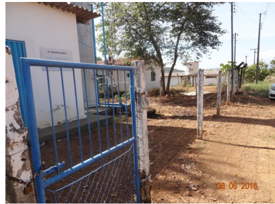
Foto 4 – REL com cerca de proteção recuperada.
