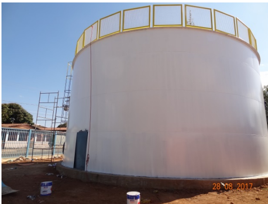
Foto 1 – RAP novo – 500 m 3
