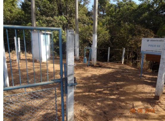
Foto 2 – Poço 02 com cerca de proteção.
