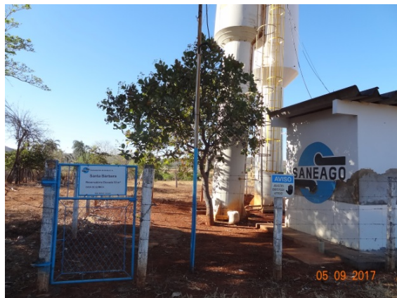
Foto 4 – REL antigo e danificado
