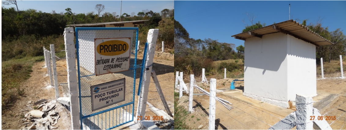
Foto 1 – Cerca do poço 1 recuperado Foto2 – Casa do quadro de comando recuperada
