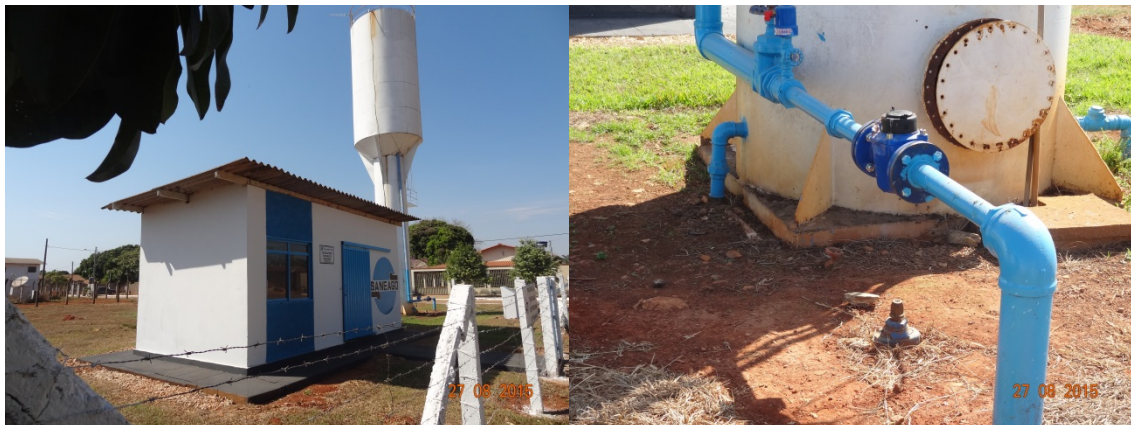
Foto 3 – Revestimento e pintura recuperada Foto 4 – Macromedidor instalado
