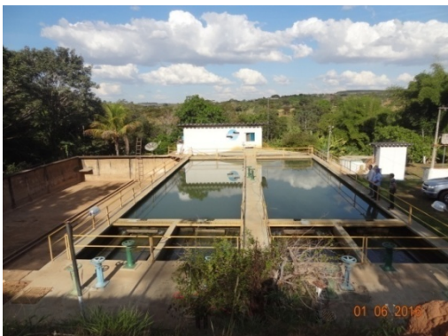
Foto 3 - Área para ampliação capacidade captação sist. Santana
