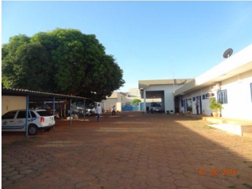
Foto 7 -Reformas da área administrativa / escritórios
