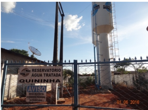
Foto 5 - Manutenção área e casa de cloração sist. D. Quinha
