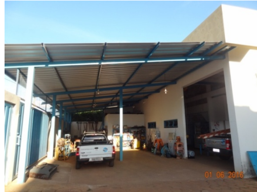
Foto 8 -Reforma da área de manutenção / oficinas
