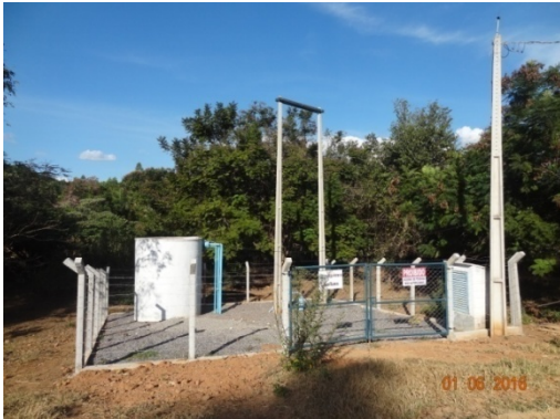
Foto 1 - Melhorias no sistema de abastecimento de água- interligação poços.
