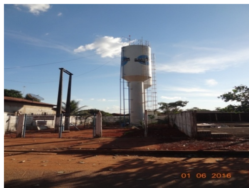
Foto 4 - Manutenção área e casa de cloração sist. D. Quinha
