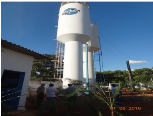
Foto 9 -Manutenção de áreas de reservatórios
