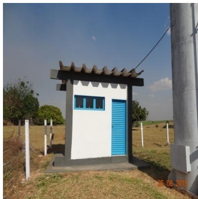
Foto 3 – Casa do clorador com pintura recuperada
