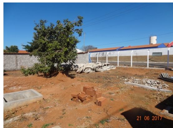
Foto 10 – EEAT/Booster Setor Parque dos Buritis área em reforma.
