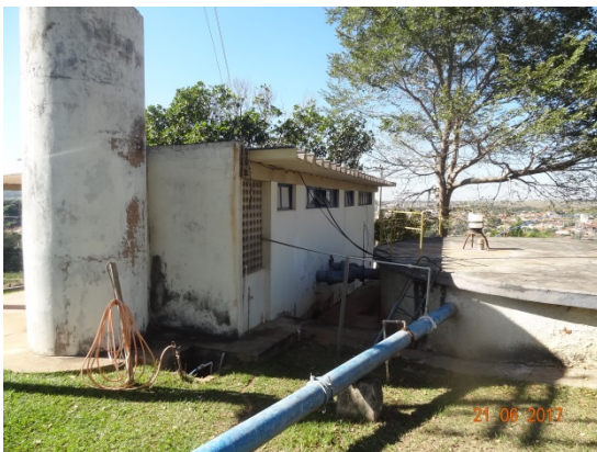
Foto 15 – RSE da ETA com escada de acesso ao topo improvisado.
