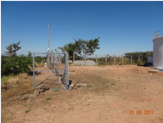
Foto 11 – RAP Ponte de Pedra, área com cerca aberta.
