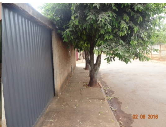
Foto 10 - Parte da rede de coleta construída
