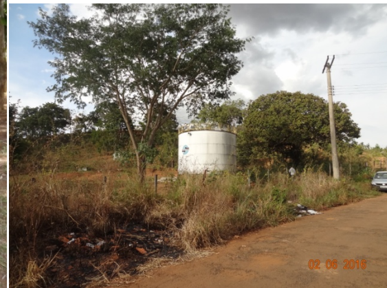
Foto 4 -Novo reservatório metálico instalado - 2.000 m 3
