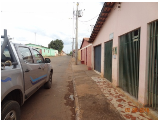
Foto 9 - Parte da rede de coleta construída
