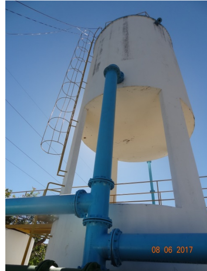
Foto 2 – REL da ETA com pintura recuperada
