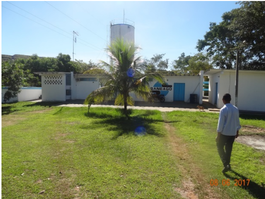
Foto 1 – Edificações da ETA com pinturas recuperadas
