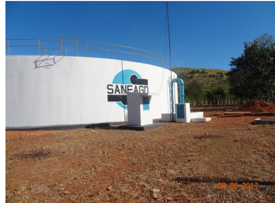
Foto 6 – RSE 2700m 3 com guarda-corpos e pintura recuperada
