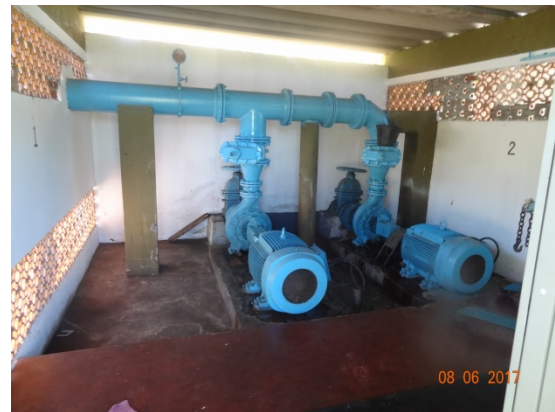
Foto 4 – EEAT da ETA com pintura recuperada
