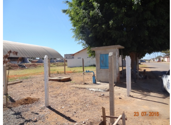
Foto 2 – Poço 15 (Cruzeiro do Sul) – ausência de cerca e identificação
