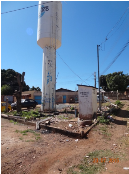
Foto 3 – Poço 10 (Cruzeiro do sul) – local em péssimas condições de segurança, limpeza e proteção
