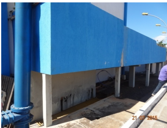
Foto 1 – Presença de infiltrações e eflorescência na calha Parshall
