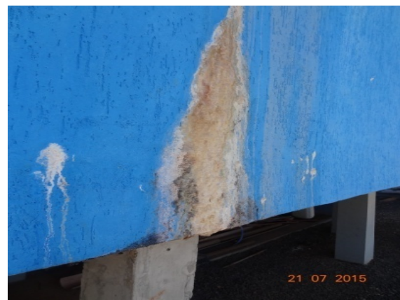
Foto 1 – Presença de infiltrações e eflorescência na calha Parshall
