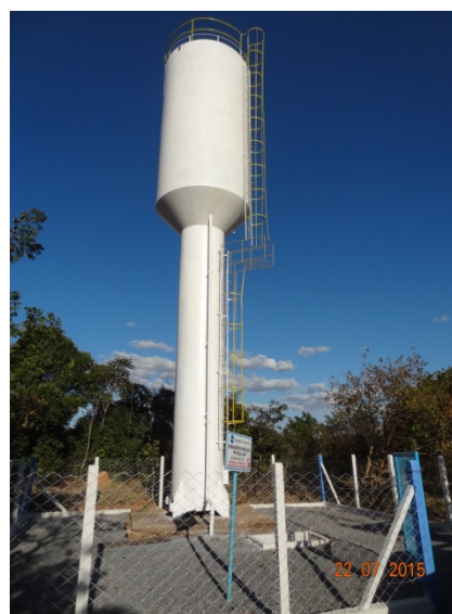
Foto 2 – Recuperação e pintura do reservatório
