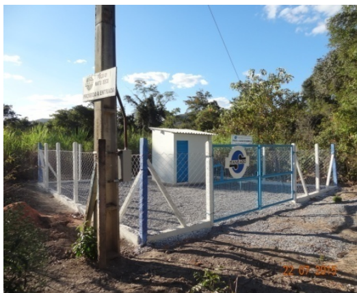
Foto 1 – Recuperação da cerca na área do poço
