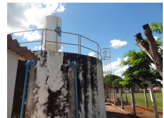
Foto 6 - Reservatório/installação de guarda corpos
