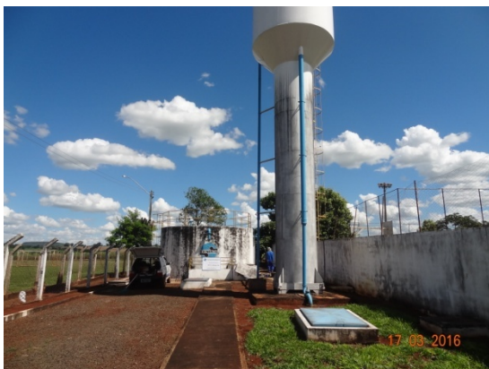
Foto 3 - Reservatório/manutenção da área e cerca
