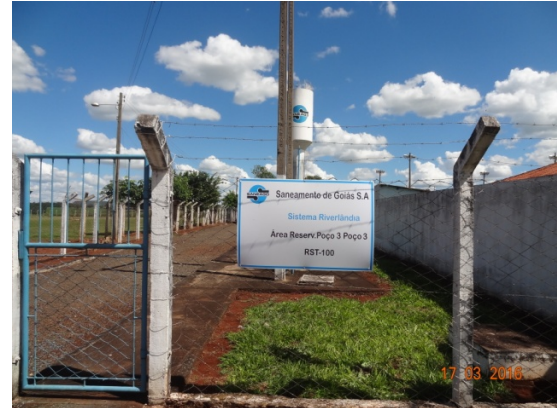
Foto 2 - Reservatório / sala do clorador / manutenção da área e cerca
