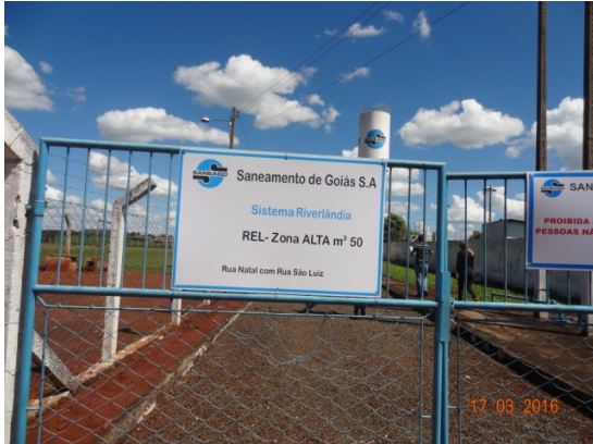
Foto 1 - Reservatório/sala do clorador/ manutenção da área e cerca
