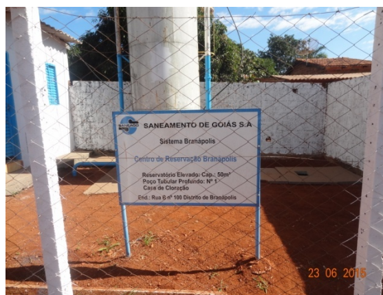
Foto 1 – Placa de identificação CR Branápolis e poço tubular profundo
