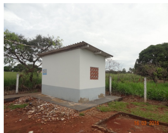
Foto 2 - Centro de Reservação / Sala do Clorador - Naveslândia
