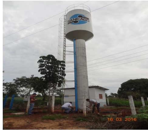
Foto 4 - Centro de Reservação / Sala do Clorador - Naveslândia
