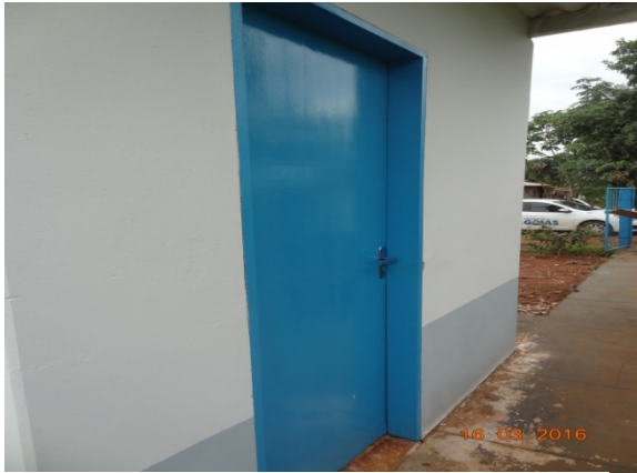
Foto 3 - Porta da sala do Clorador - Naveslândia
