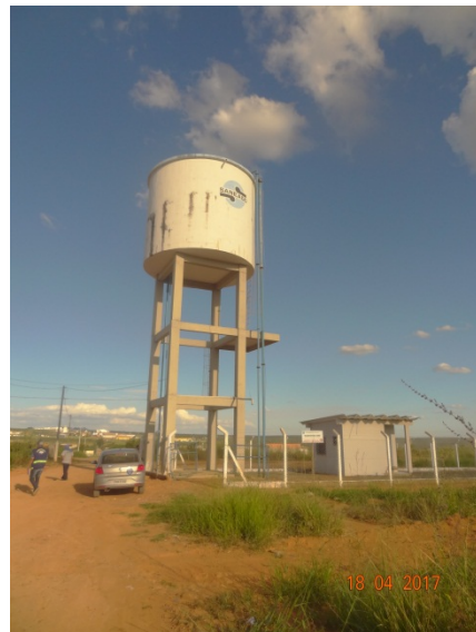
Foto 4 – REL Parque da Colina - Cerca recuperada
