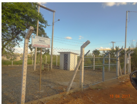
Foto 5 – Poço 02 - Setor Bela Vista - Cerca recuperada
