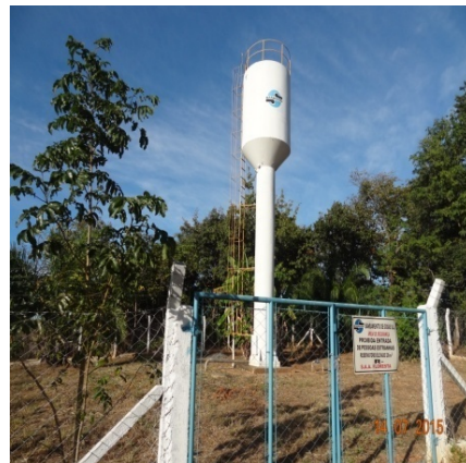
Foto 2 – Res. R-1 guarda-corpo instalado
