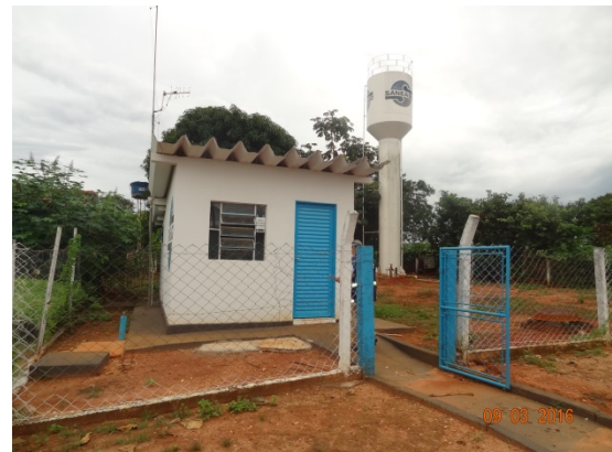
Foto 6 – Casa do clorador recuperada
