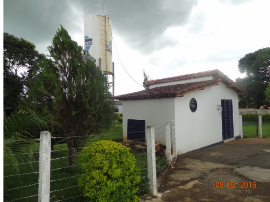
Foto 1 – Escritório com pintura recuperada
