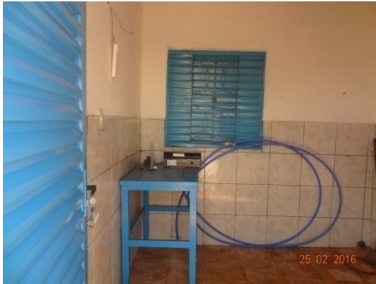
Foto 1 –Recuperação de pintura de revestimento
