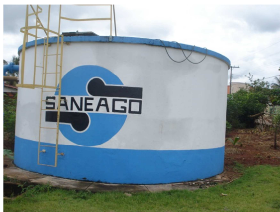
Foto 2 – RAP 30m 3 desativado
