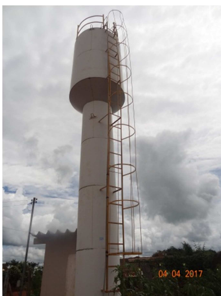
Foto 1 – Reservatório Elevado com guarda-corpos
