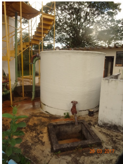
Foto 1 – Poço de contato recuperado
