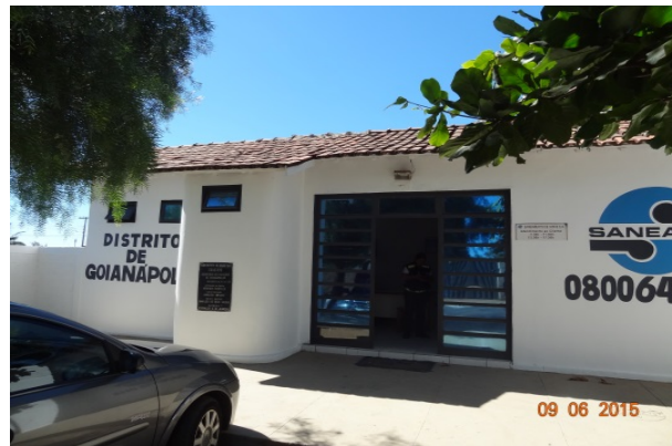
Foto 1 – Escritório com pintura recuperada
