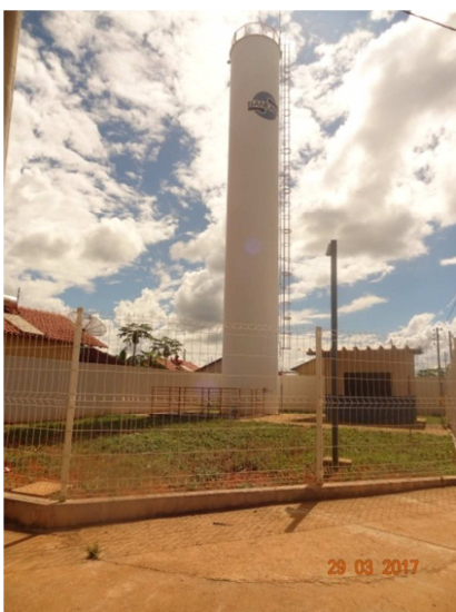
Foto 5 – Limpeza das áreas dos reservatórios executadas
