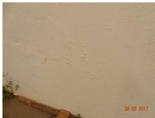
Foto 2 – Infiltrações corrigidas
