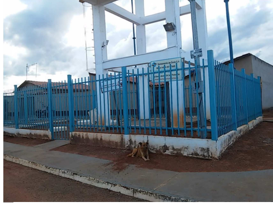
Foto 8 – Cerca de proteção concertada
