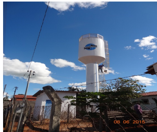
Foto 4 – Vista da sala do clorador
