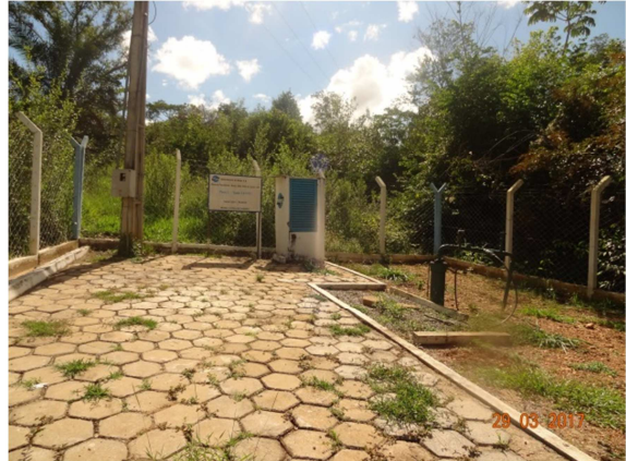
Foto 4 – Poço 3 pintura recuperada
