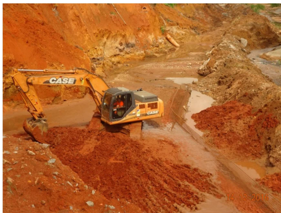
Foto 20: Obras de contenção de erosão Córrego Almeida (dezembro)
