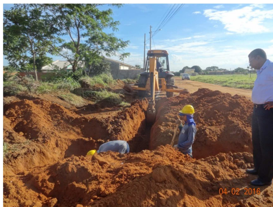
Foto 26: Execução de rede no Bairro Buriti Sereno (fevereiro)
