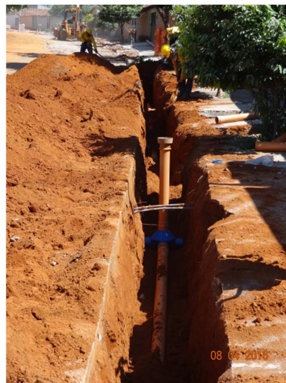
Foto 6 – Execução de rede (abril)
