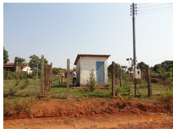
Foto 2 – Poço 02 sem identificação
